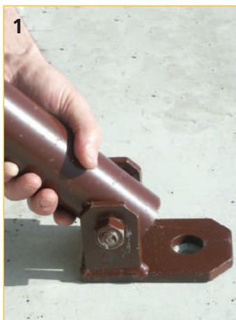
1. Posicionar la pieza de construcción aproximadamente sobre el punto de anclaje
