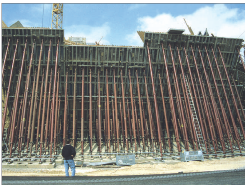
Tipo BKS en construcción de encofrados: contrafuertes de puentes
