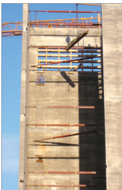
Tipo BKS en construcción de encofrados deslizantes
