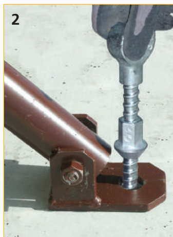
2. Atornillar tornillo hasta el fondo de anclaje
