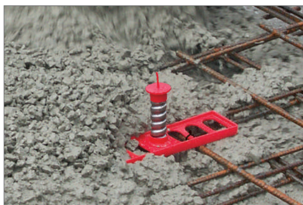
El juego de montaje se asienta fuerte en la armadura y sigue en posición vertical. Después de alisar el punto de anclaje se puede volver a encontrar fácilmente por el pin flexible en el tapón de marcación.
