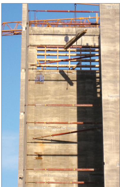
Tipo BKS en construcción de encofrados deslizantes
