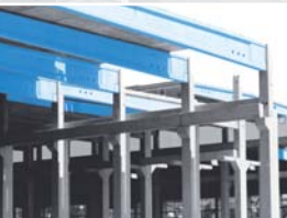
Pretensado de estruc- tura prefabricada
