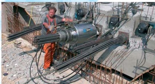
Dib. 12: Prensa de tensar multifilar TENSA M 4800 kN
