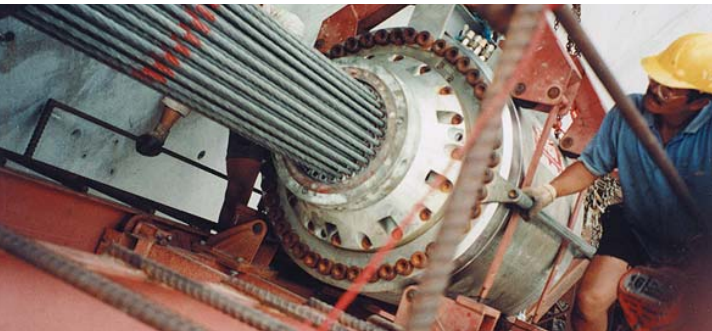
Dib. 18: TENSA M 15000 kN en servicio
