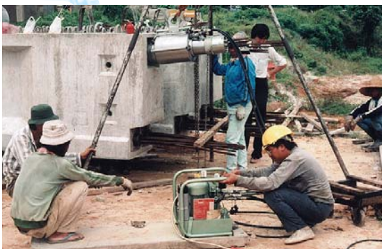
Dib. 13: Agregado de bomba portátil y prensa multifilar para el pretensado con unión posterior en servicio móvil
