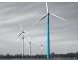
Tensado de torres y postes
