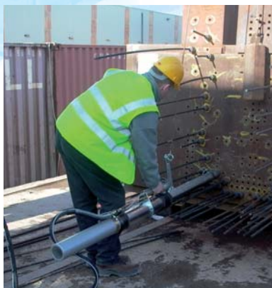
Dib. 10: Prensa de 2 mangueras 250 kN en uso
