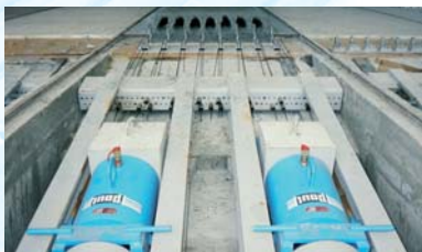
Dib. 7: Anclajes de tracción
