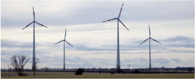
Dib. 23: Instalaciones eólicas con torres de hormigón tensados
